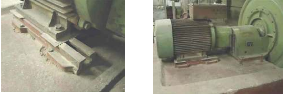
Рис.7. Фото опорной конструкции воздуходувки GRF300/1150 5010.1 до ремонта.
