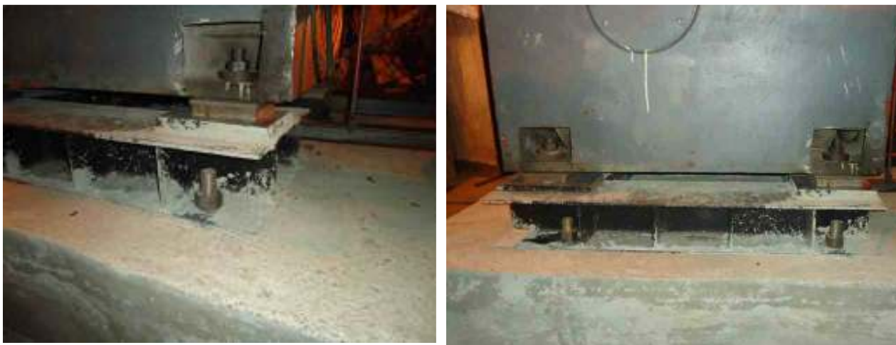
Рис.18. Фото опорной конструкции ЭД насосного агрегата СЭ после ремонта
