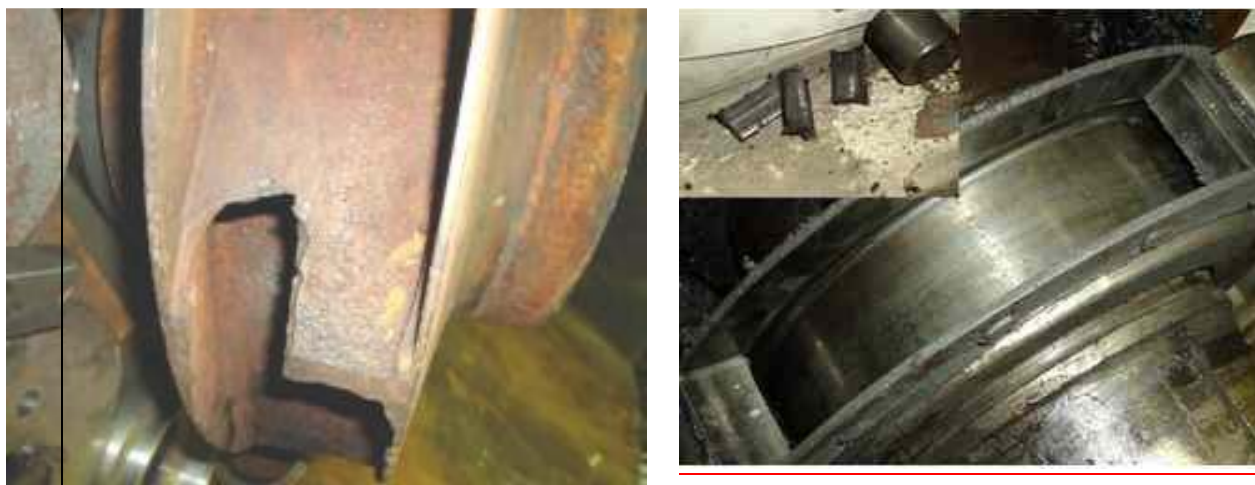
Рис.5. Фото демонтированного рабочего колеса с дефектом одной лопатки (слева) и подшипника опоры 4(справа).
